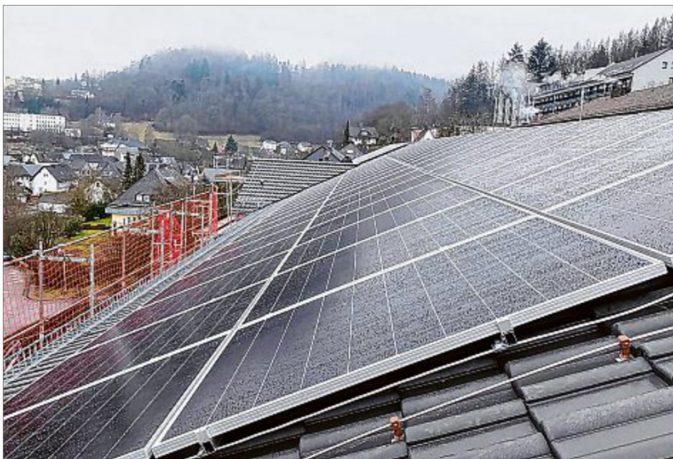
88 Photovoltaik-Module wurden auf dem Neubau des August-Hermann-Francke-Hauses in Bad Laasphe installiert.
