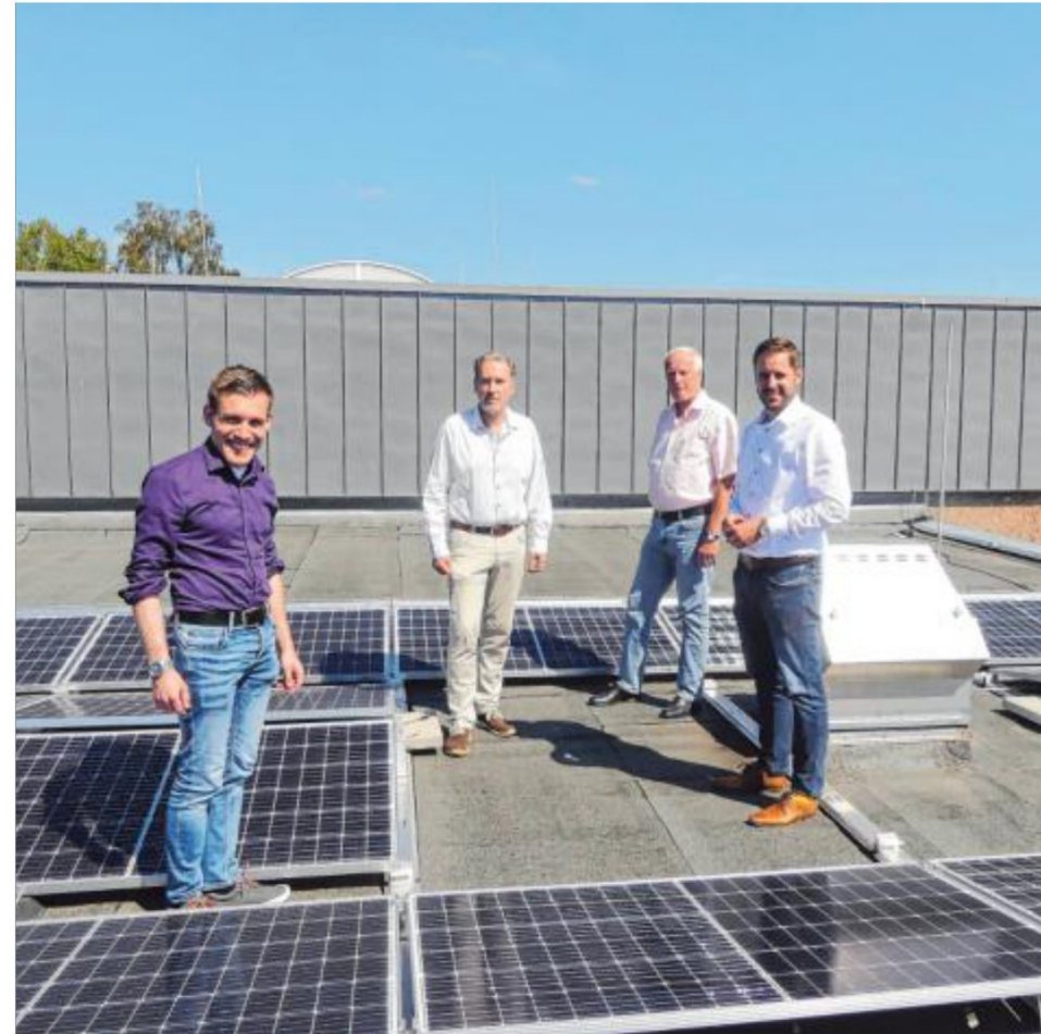
Die Energiegenossenschaft Wittgenstein setzt verstärkt auf die Karte Photovoltaik.
